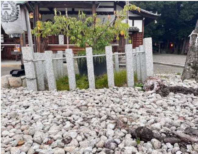
①⑦ 樹木根によよって大きく傾く石柱
