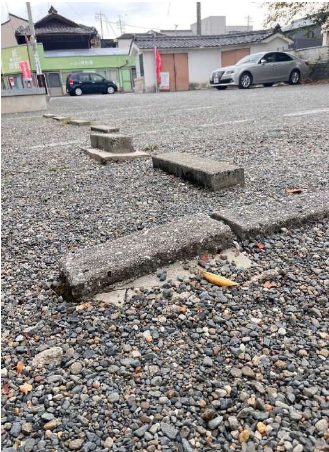
⑤ ズレた車線と基礎がむき出して傾いた車止め
