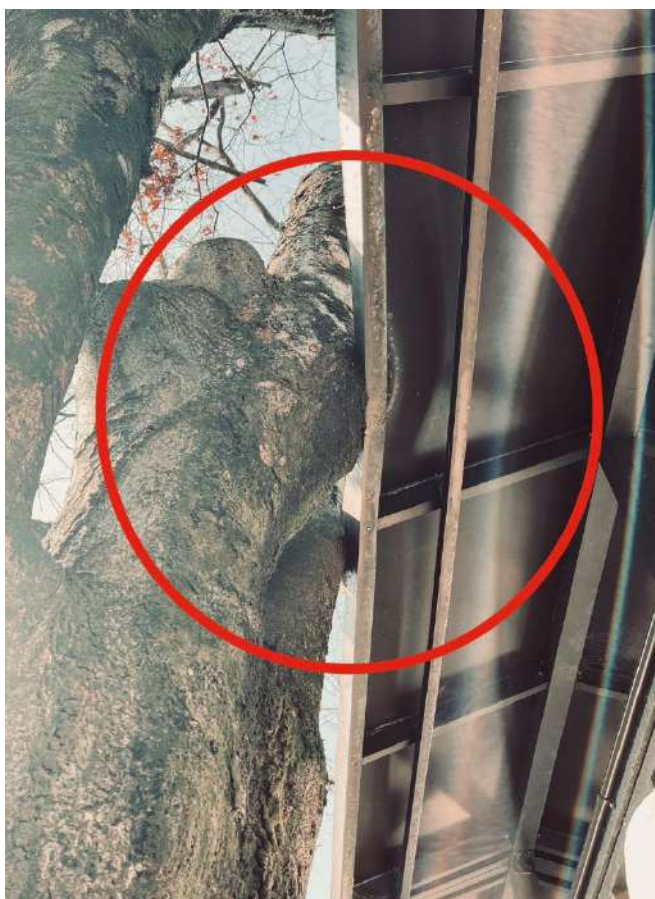
⑬ 樫の成長により提灯屋形と接触して歪む屋根 樫の内部空洞化
